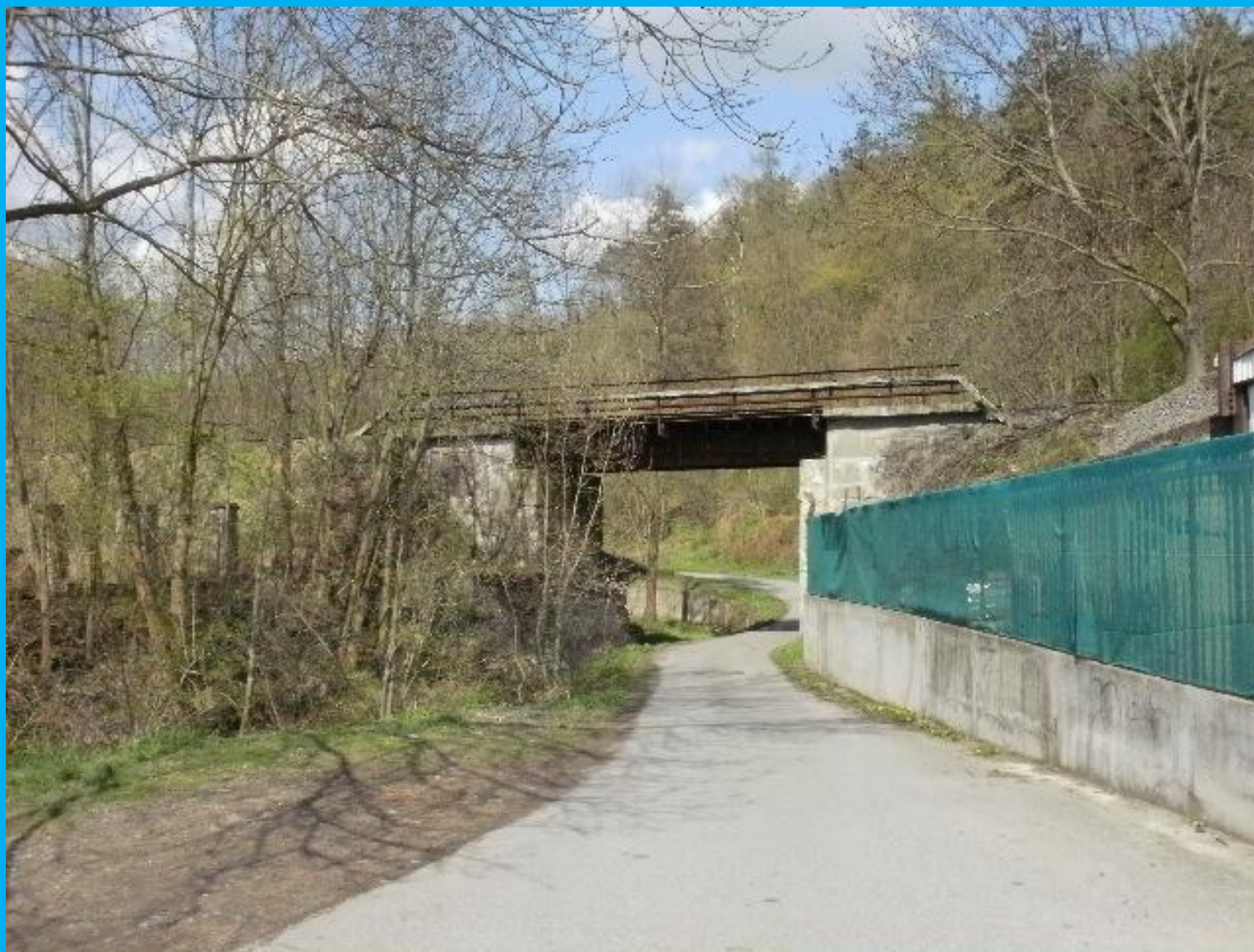
...železniční most v Hýskově přes místní komunikaci
