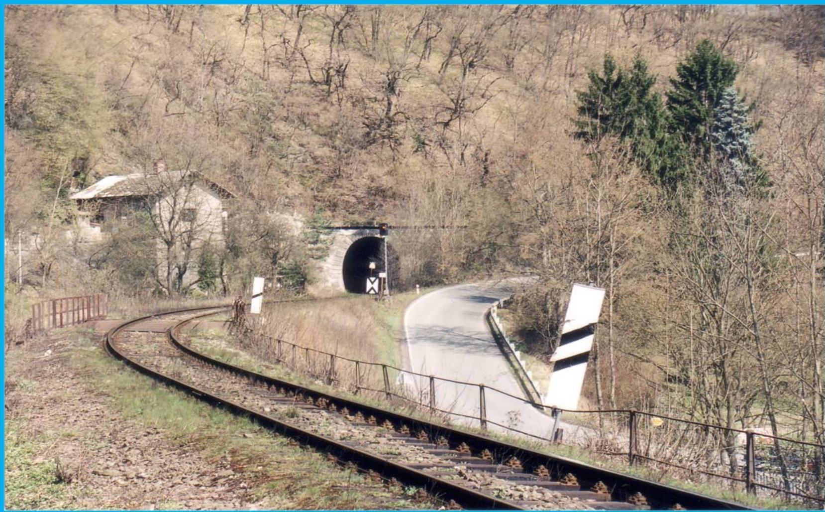
Současný pohled na portál křivoklátského tunelu u sv. Josefa se světelnou předvěstí vjezdového návěstidla do Městečka. Původní úroňové křížení silnice s tratí bylo nahrazeno úpravou trasy silnice ve 30. letech minulého století
