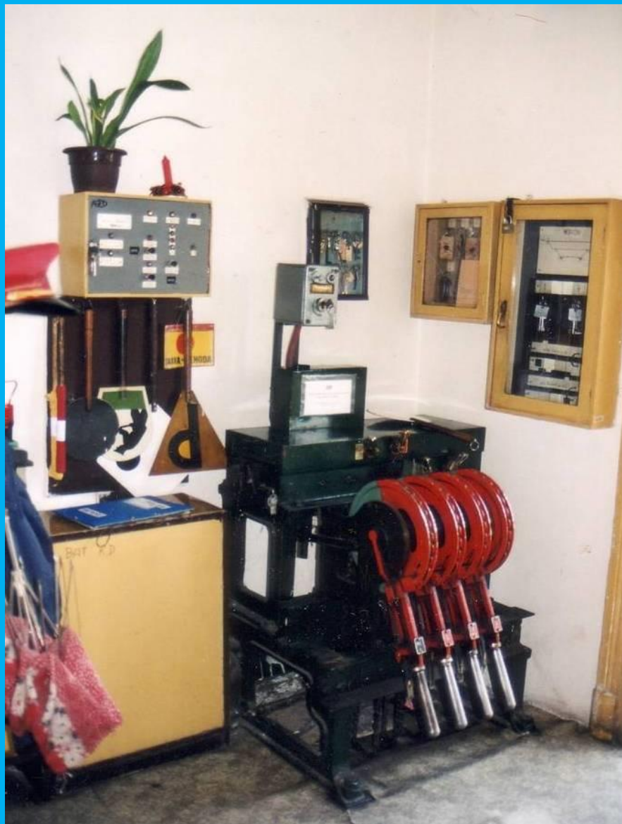
Stavědlový přístroj v dopravní kanceláři bývalé železniční stanice Městečko je zakonzervován.
