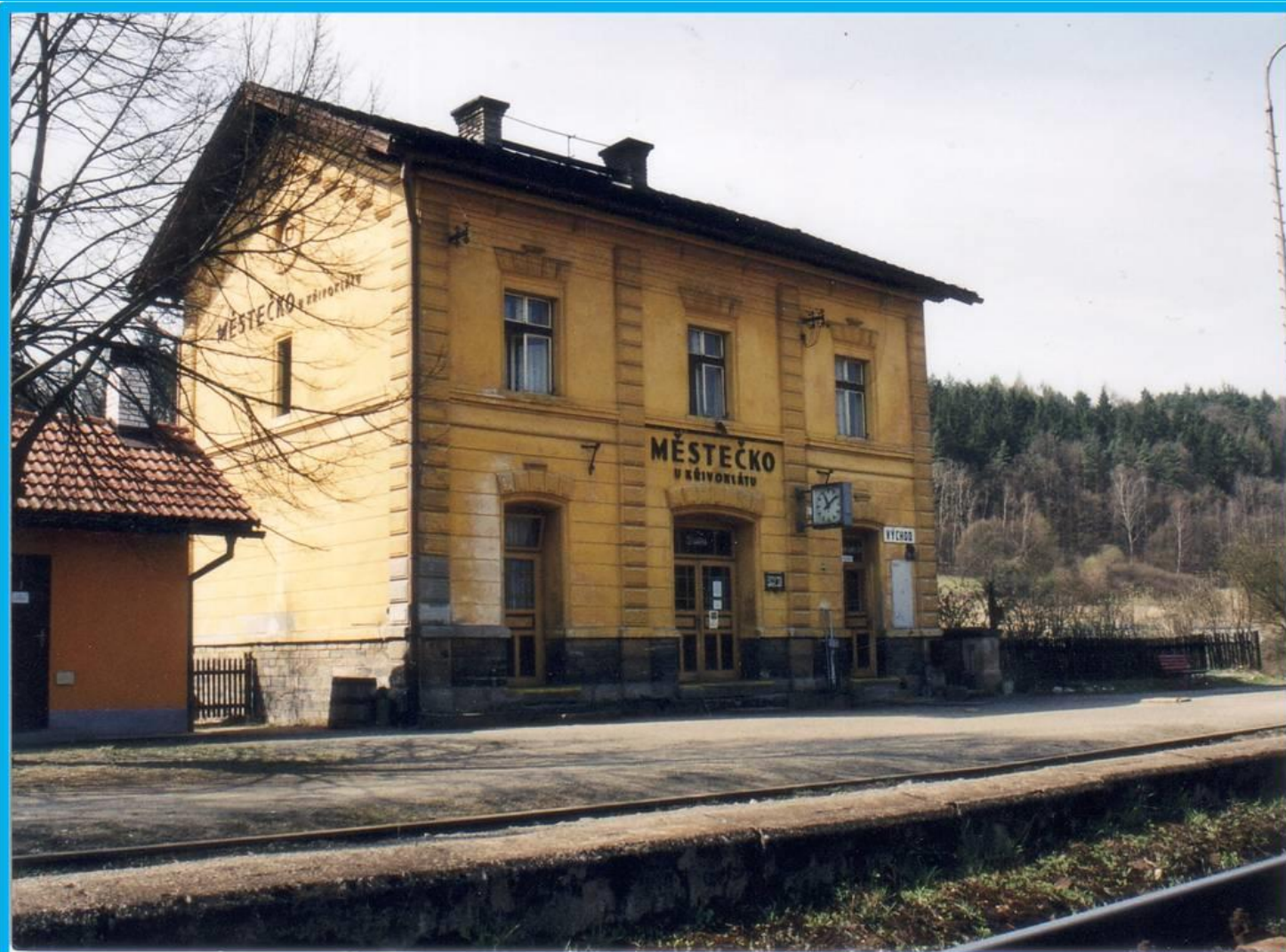
Typizovaná staniční budova v Městečku v základní třídlínné variantě. Stanice je dnes zastávkou. Do roku 1918 se obec jmenovala Stadtl a stejně tak byla stanice označena v jízdním řádu
