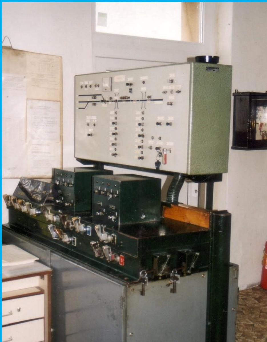
Řídící přístroj v dopravní kanceláři žel. stanice Hýskov z druhé poloviny 90. let minulého století je „zdařilou“ kombinací starých mechanických verglů s elektrickými hejblátky a žárovčičkami
