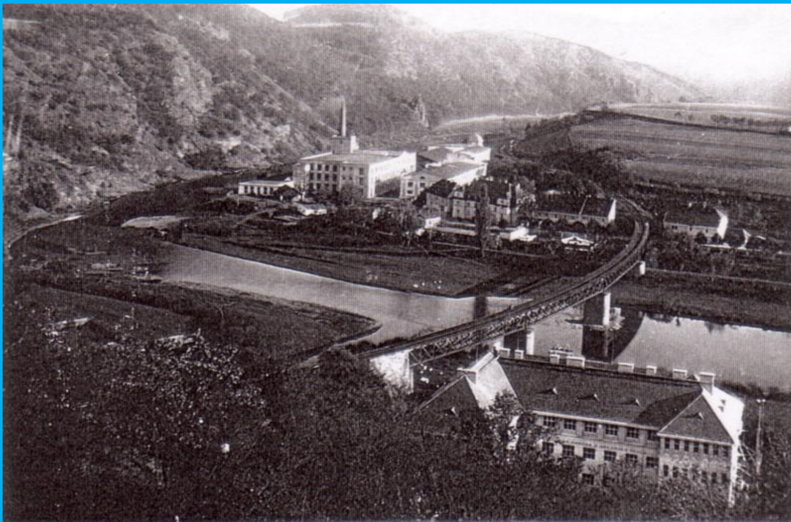
Náš historický vláček přešel za stanicí Křivoklát původní příhradový most s dolní mostovkou , postavený v oblouku o poloměru 285 m
